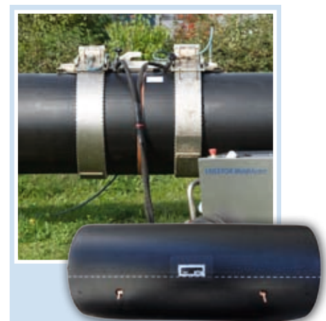
Schweißgerät und Muffe: Das Schweißgerät wird auf der Grundlage individueller Produkt- und Schweißdaten, die auf dem RFID-Transponder gespeichert sind, korrekt eingestellt.
